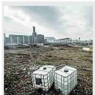
Ex Falck L'area dei cantieri
